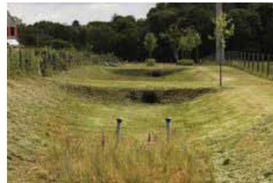
Exemple d'une noue de grande capacité
