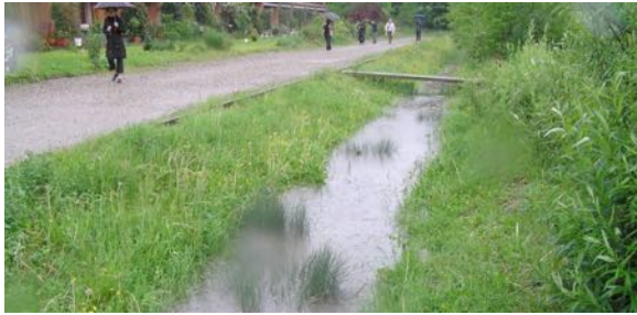
Exemple de traitement d'une noue pour une ambiance urbaine
