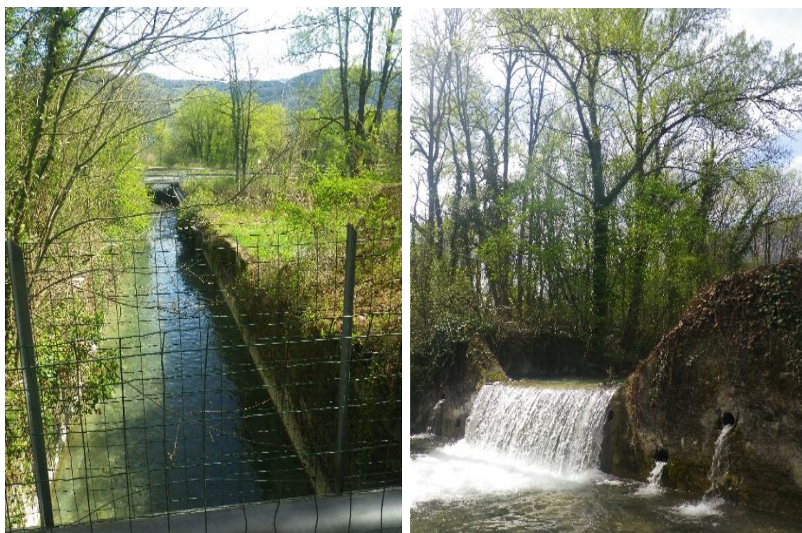
Passage sous l'A41 (à gauche) et seuil (à droite)
