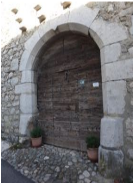
La Maison Forte du Carre , avec deux tours circulaires et un porche surmonté de 4 corbeaux à double ressaut.
